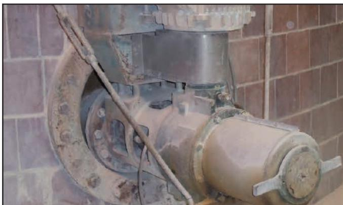
Eines der vier Schlamm-tank-Rührwerke, auf denen Inpro/Seal Air Mizers (Sperrluftdichtungen) installiert wurden, um Produktverlust zu eliminieren und die Wartungskosten zu senken.
